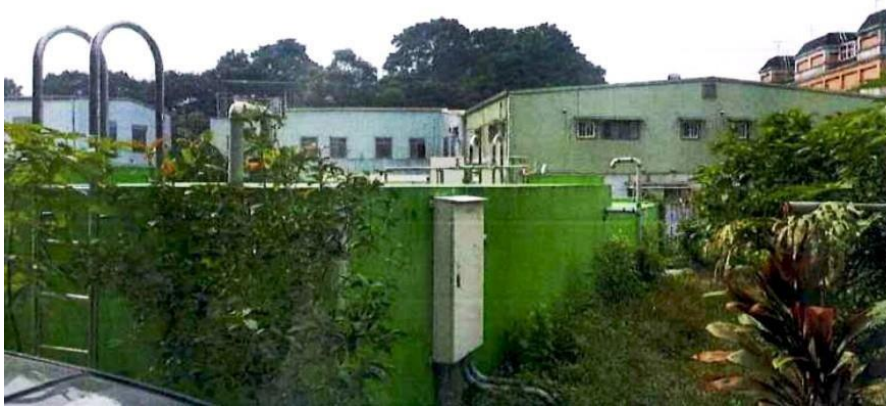
碧澄社區群供水設備〈受水池〉*新店區秀山路實景
