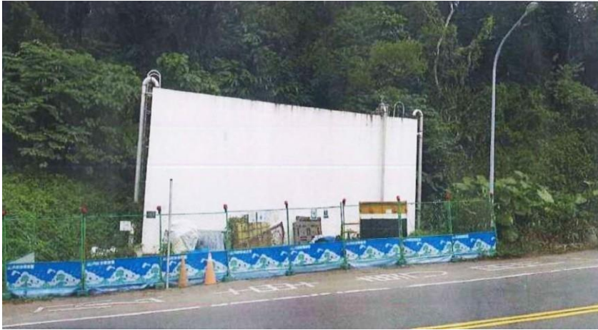
碧澄社區群供水設備〈配水池〉*新店區華城路 62 號對面實景
